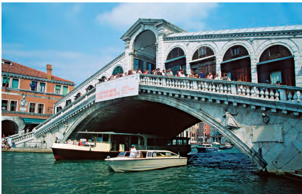
Most Rialto w Wenecji, posadowiony na 12 tysiącach drewnianych pali (fot. P.F.)
